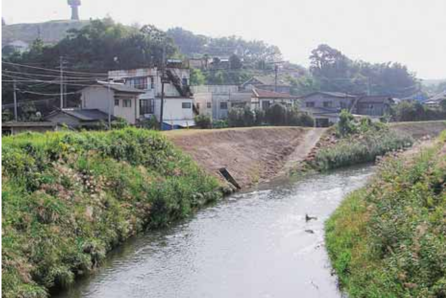
逆流し浸水被害をもたらした大隅支所付近河川
