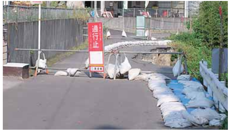
大隅町馬場・竹山線の道路災害
