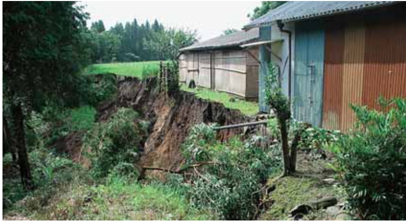
大隅町中尾地区の災害現場
