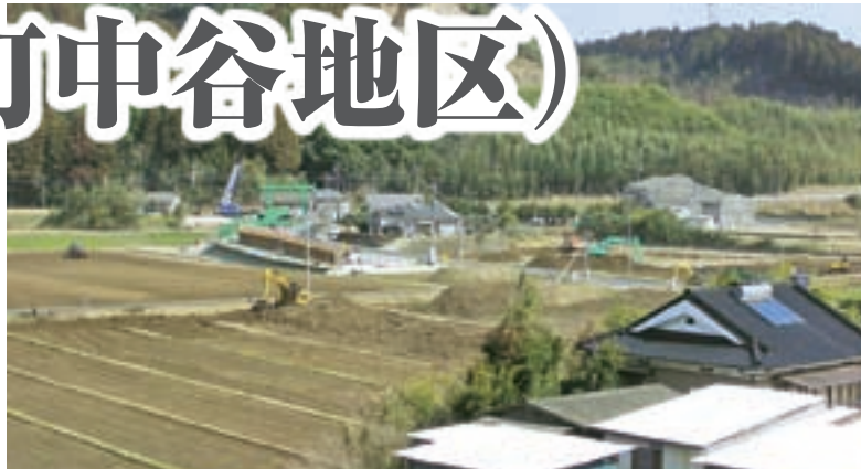
災害復旧工事状況 (3月)
