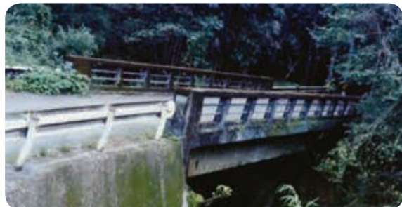
昭和40年に建設された浅井橋
