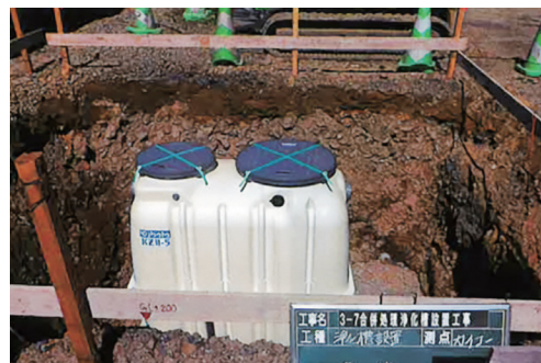
浄化槽設置の様子
