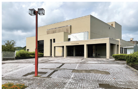
雨漏りのする冷房の効かない大隅文化会館
