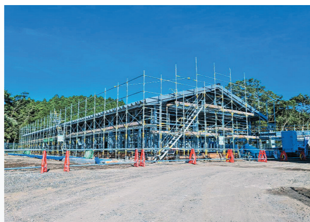
▲ 建築中の厩舎
