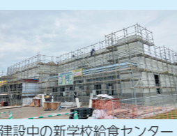
建設中の新学校給食センター
