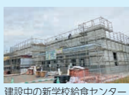
建設中の新学校給食センター
