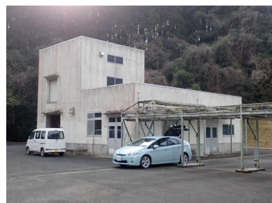
財部一般廃棄物 最終処分場
