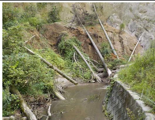
白毛川護岸補修
