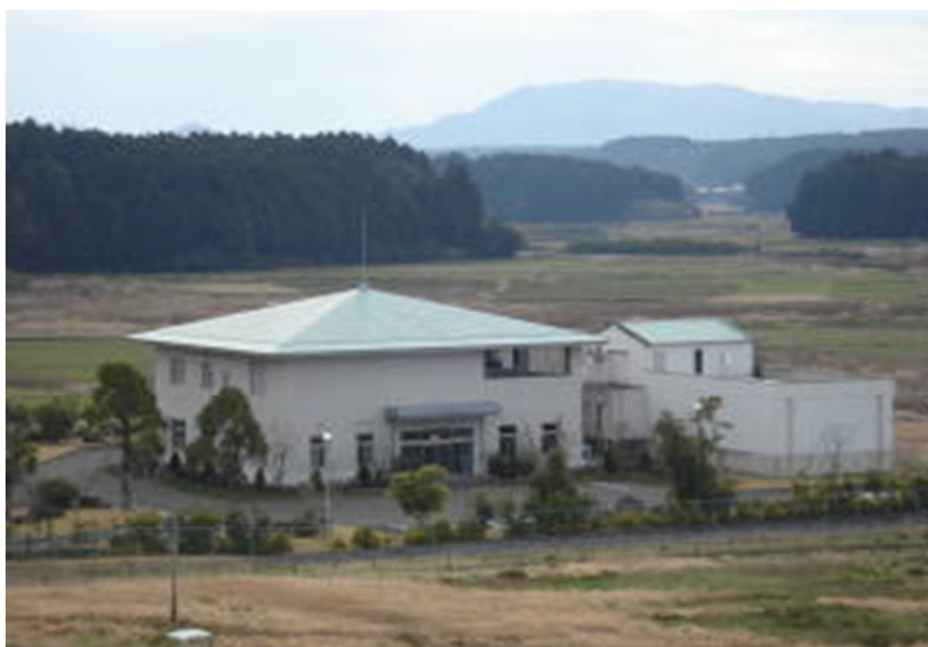
曾於市下水道浄化センター
