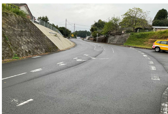
区画線設置工事
