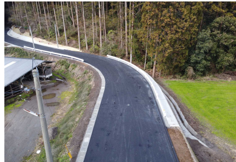
市道整備事業 麓・橋野線
