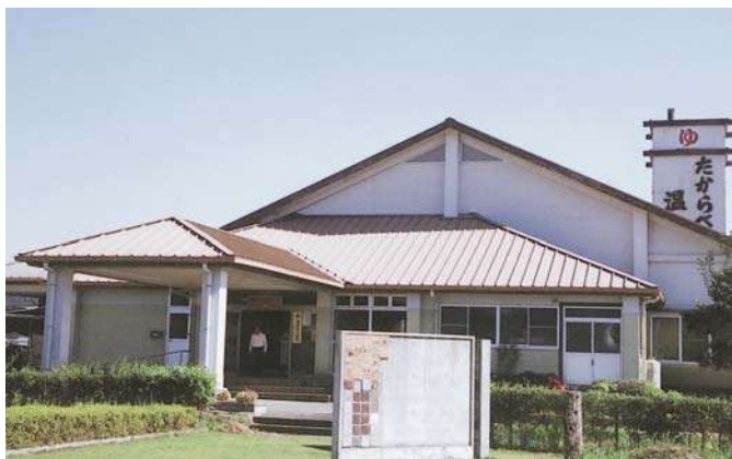
新たな泉源掘削される財部温泉センター
