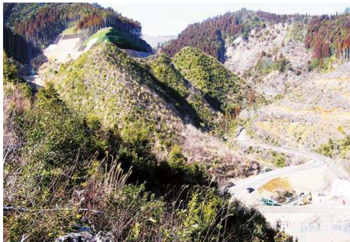
北部畑かん谷川内ダムの建設現場
