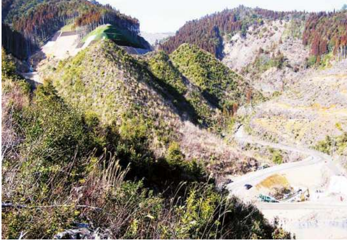
北部畑かん谷川内ダムの建設現場
