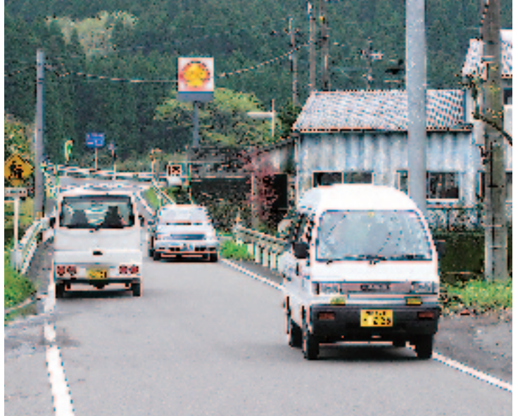
改良が望まれる県道
