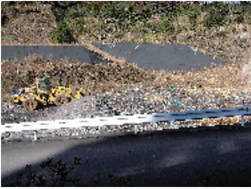
大隅一般廃棄物最終処分場
