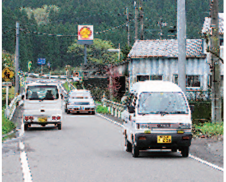
改良が望まれる県道
