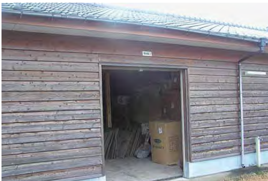
災害時の毛布等が収納されている柳迫倉庫
