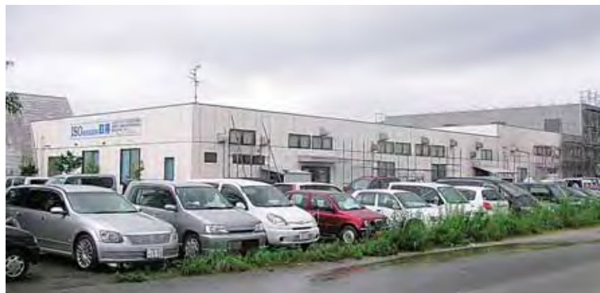
工場増設をする(株)ジャスティ (財部工業団地内)
