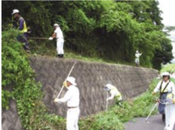
建設同志会によるボランティア清掃
