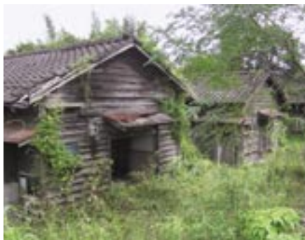
解体される平原団地
