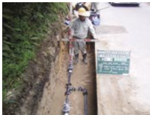
水道管布設替工事の様子
