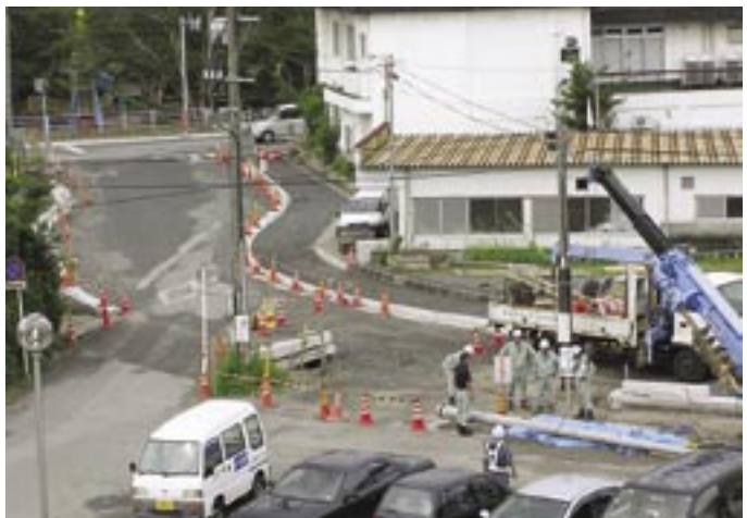
役場通線改良工事現場
