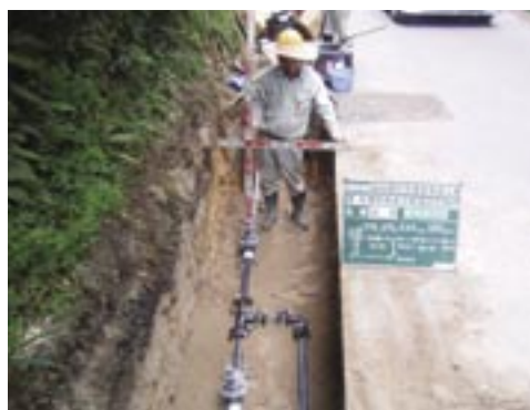
水道管布設替工事の様子
