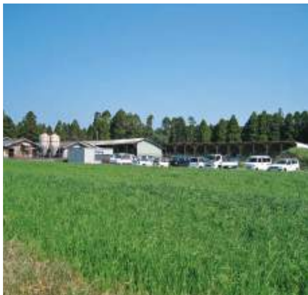
建築中の豚舎
