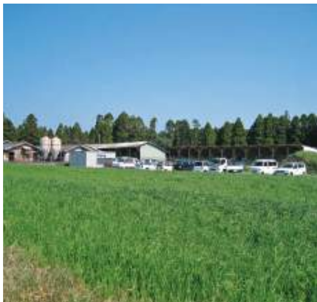
建築中の豚舎
