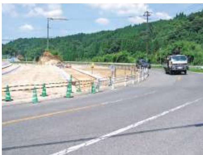
主要地方道 垂水・南之郷線（大隅町上馬場）
