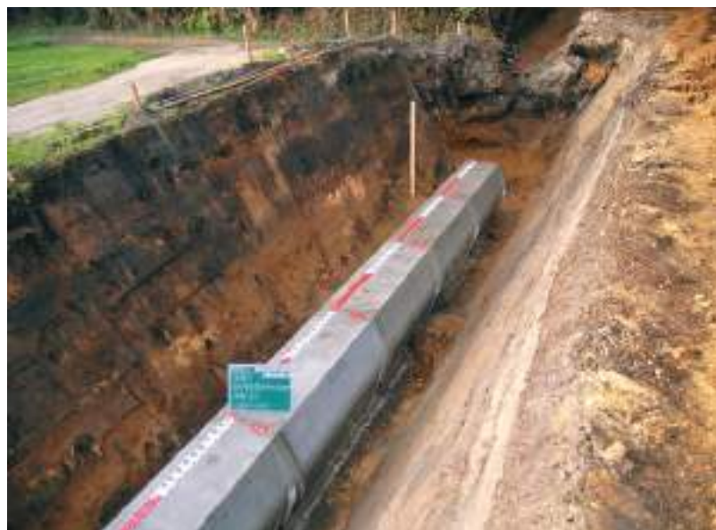
電源立地対策交付金による排水工事（大隅町八合原）
