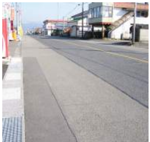
市道本通線（大隅町あけぼの付近）
