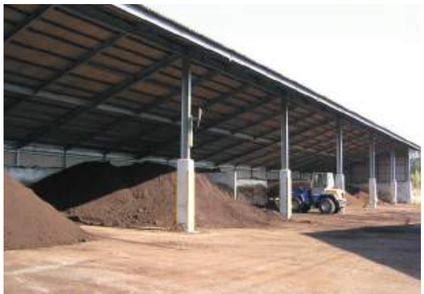
有機センター製品棟
