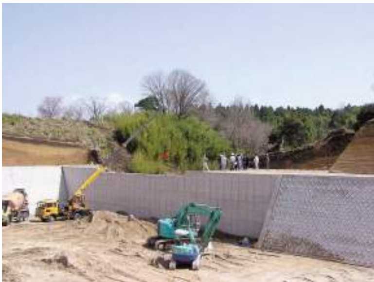
建設中の調整池
