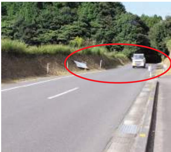
改良が望まれる県道塚脇財部線
