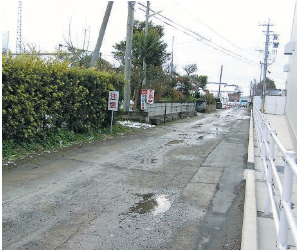
整備が始まった八合原台地の排水路
