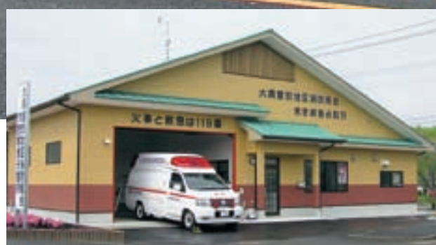
平成22年3月完成した大隅曾於地区消防組合末吉救急分駐所
