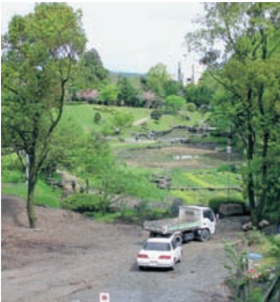
整備される向江公園の遊歩道・駐車場(末吉町)
