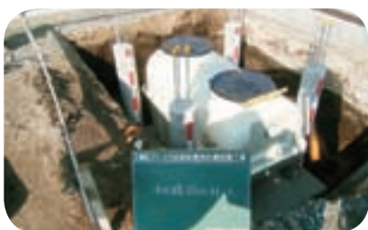
合併浄化槽据え付け状況
