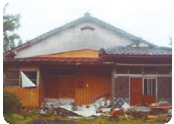
解体予定の空き家
