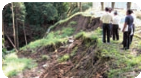
委員による現地調査
