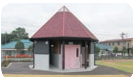
手すり設置が待たれる公園トイレ
