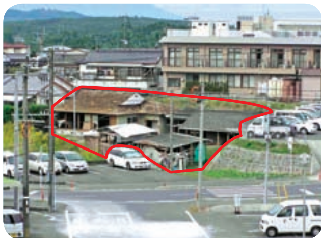
末吉庁舎北側付近の駐車場整備予定地
