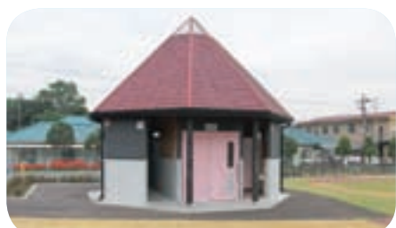
手すり設置が待たれる公園トイレ
