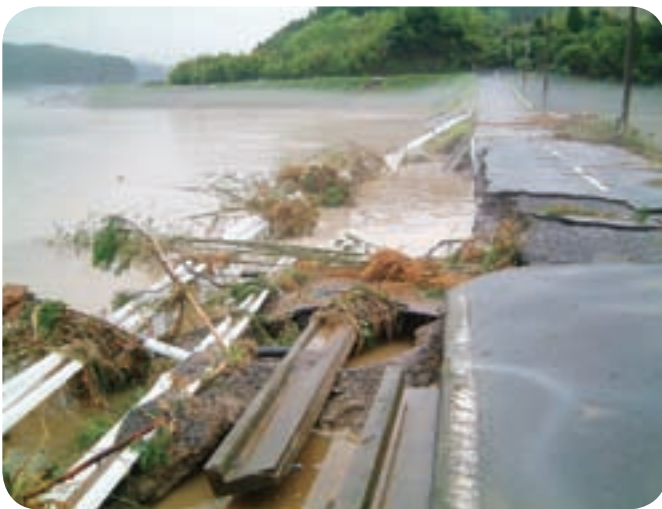
埋没した中谷地区の水田と路肩決壊
