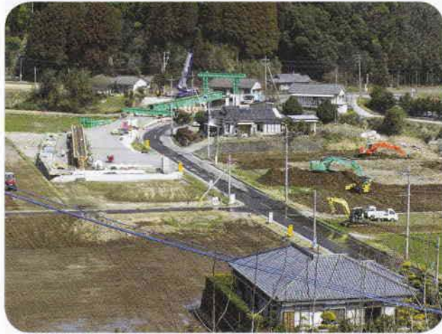
復旧が急ピッチに進む水田整備（中谷地区）
