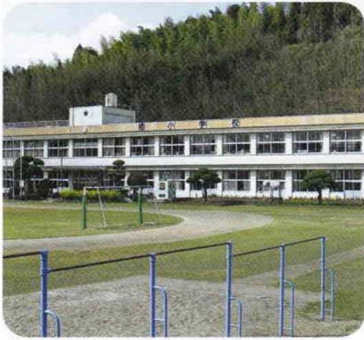
耐震補強工事が実施される榎小学校
