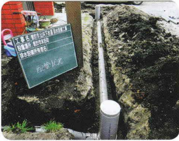
下水道への接続工事の様相
