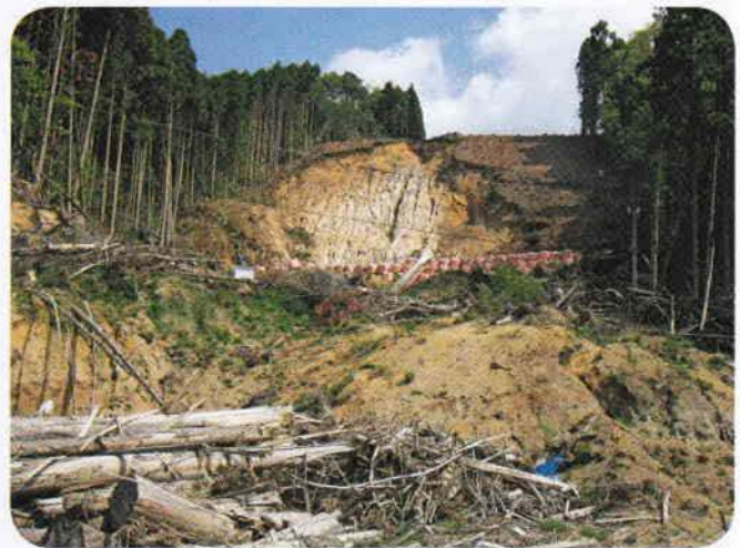
豪雨により山崩れした中谷地区
