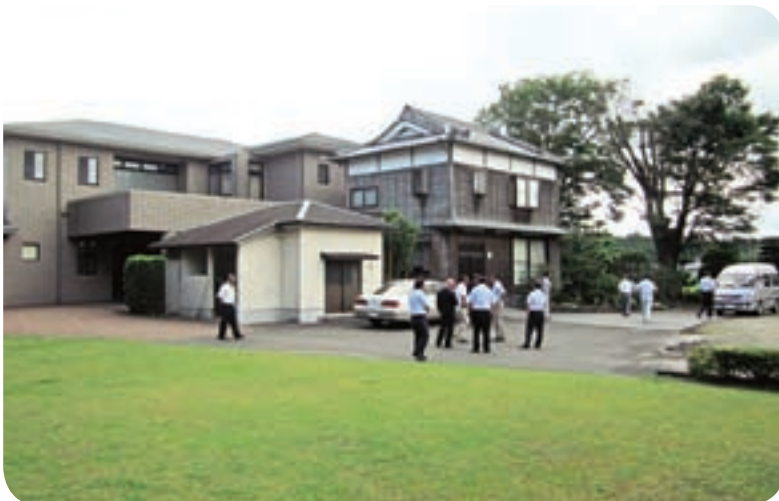
顕彰館となる山中邸を現地調査
