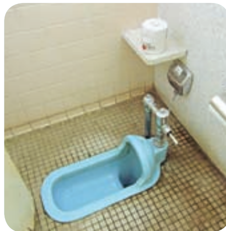
改修前トイレ（和式）
