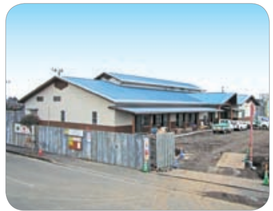
待望の大隅農産加工センター(工事中)
