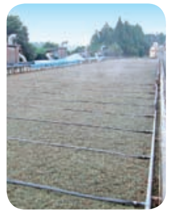
再建中の有機センター脱臭棟
