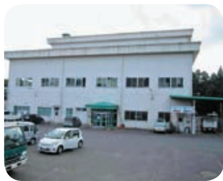
曾於市クリーンセンター全景
