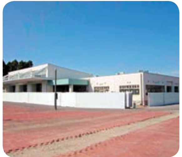
建設中のそお生きいきセンター（末吉町）
