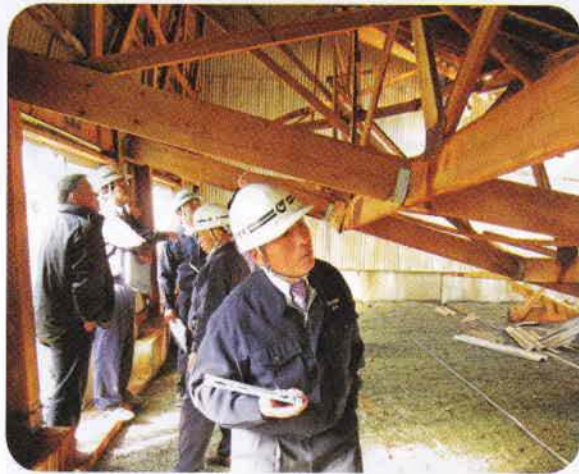
倒壊した有機センターの脱臭棟
