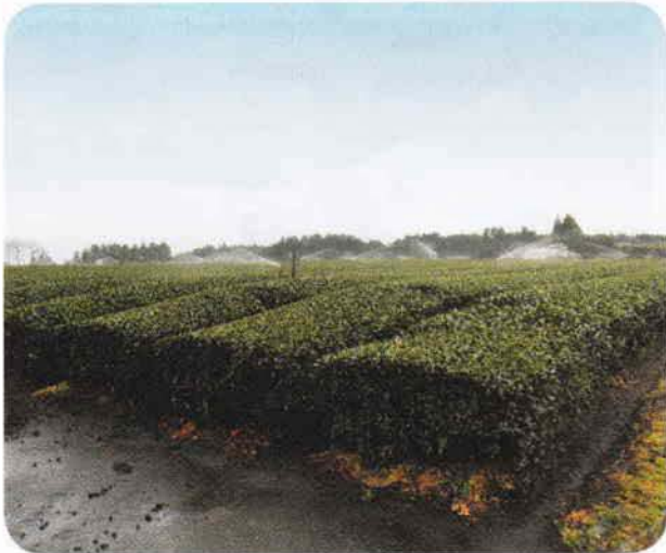
稼働中の防霜スプリンクラー
