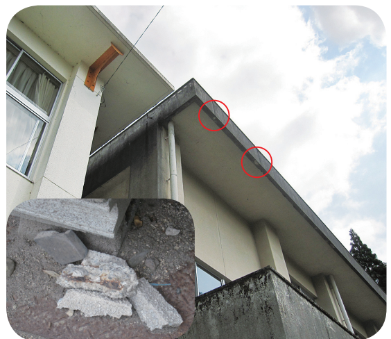
光神小学校の改修部
